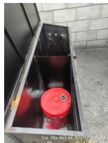
Foto 12. Interior de la zona de acopio se puede apreciar el contenedor junto dentro de un sistema de contención. Fuente: Secretaría de Ambiente
